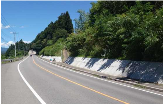
法砂ブロック 施工実績
